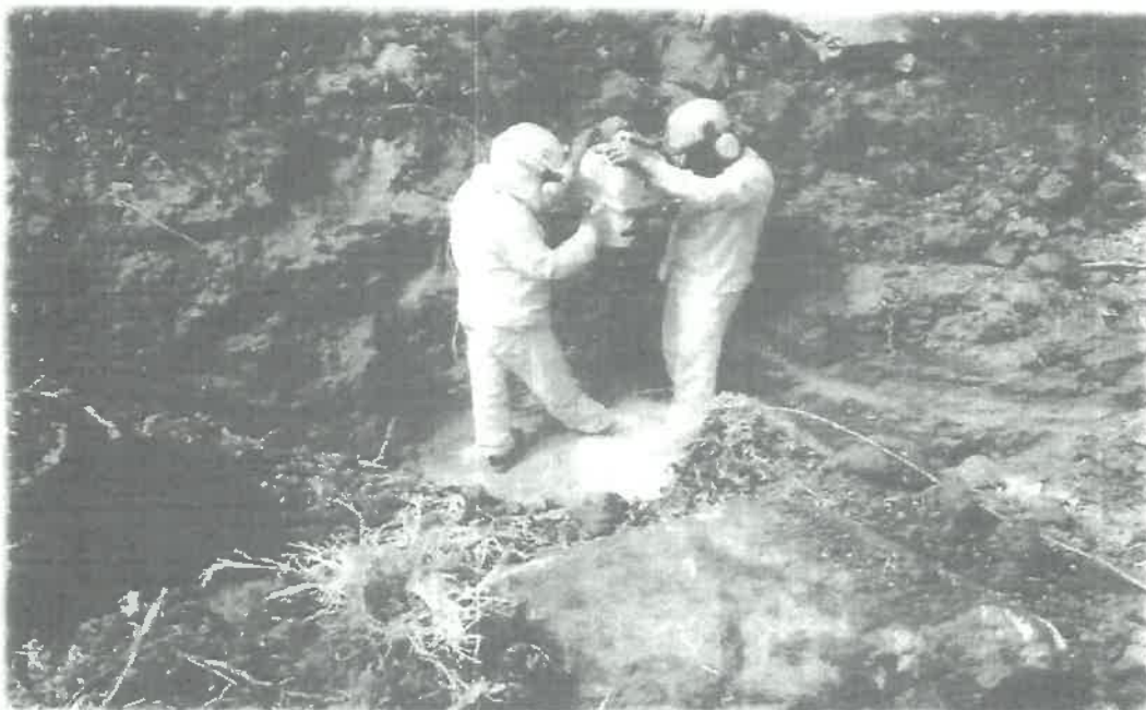
PERFORACION DE ROCA PARA COLOCAR EXPLOSIVOS
