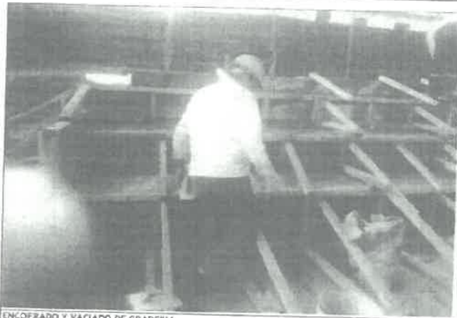
ENCOFRADO Y VACIADO DE GRADERIA
